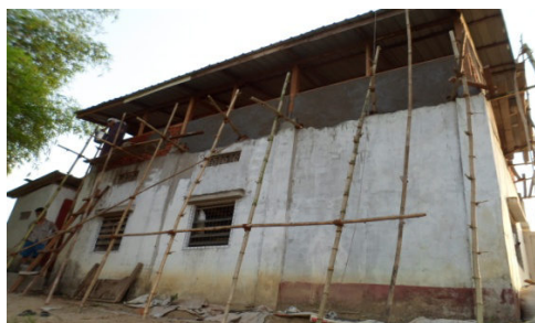
Das Mädchenhaus wurde auf normale Standhöhe aufgestockt.
